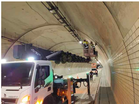
고소점검차를 이용한 근접조사
